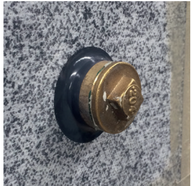
Praxisbeispiel: Rohrdurchführung mit Dichtmanschette
