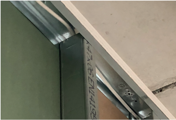
Abb. 5 - Fehlerhafte Leitungsführung; Bei einem Gleiten des Anschlusses wird die Elektroleitung beschädigt
