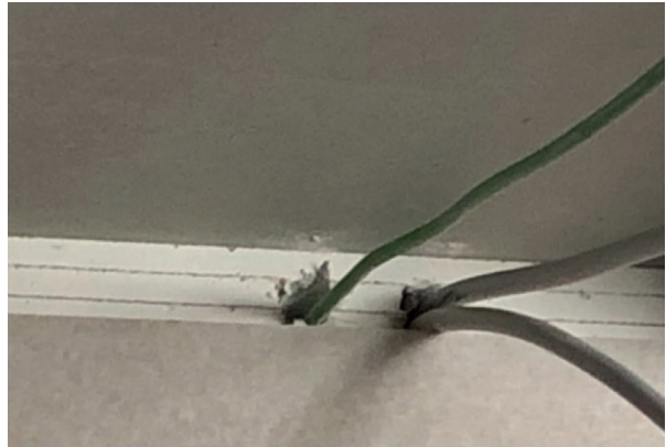
Abb. 6 - Fehlerhafte Leitungsführung; Bei einem Gleiten des Anschlusses wird die Elektroleitung beschädigt
