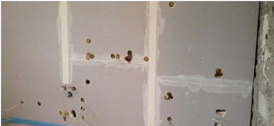
Abbildung 7 - Bohrungen für Hohlwanddosen und Leitungen
