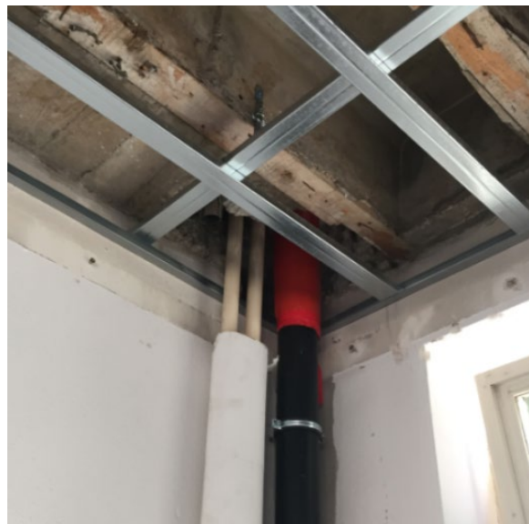
Abbildung 3 - Heizungsrohre und Abwasserleitung
