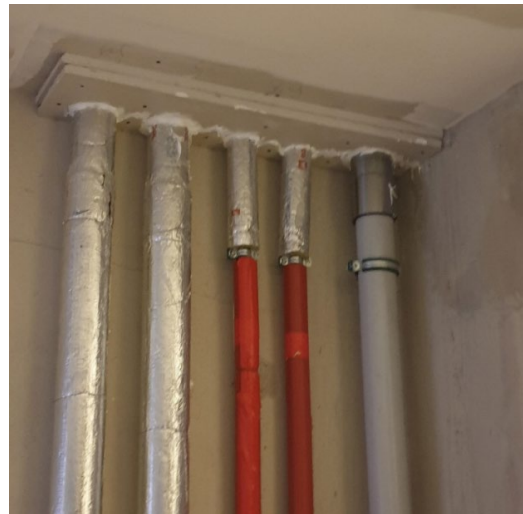
Abbildung 18 - Baustellenbild - Einzeldurchführung MLAR
