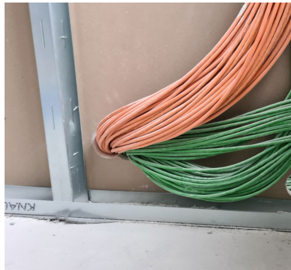
Abbildung 5 - Leitungen im Wandhohlraum
