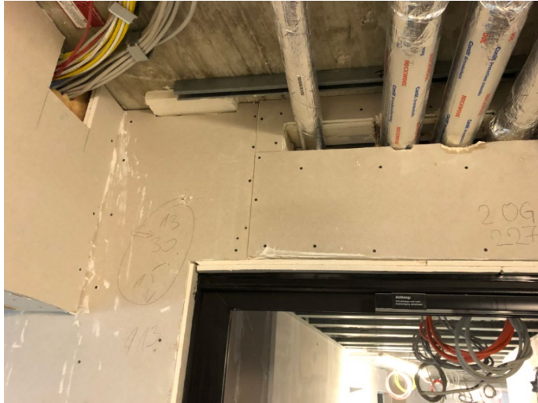
Abbildung 16 – Baustellenbild - Leitungsdurchführung durch feuerbeständige Trennwände
