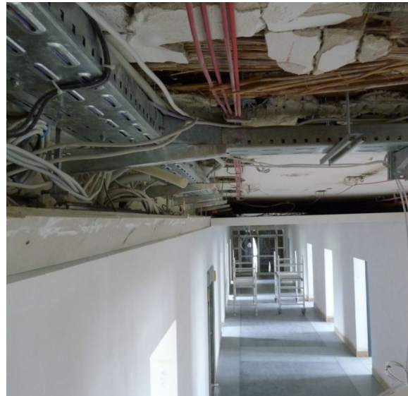
Abbildung 11 - Leitungsanlagen in notwendigem Flur
