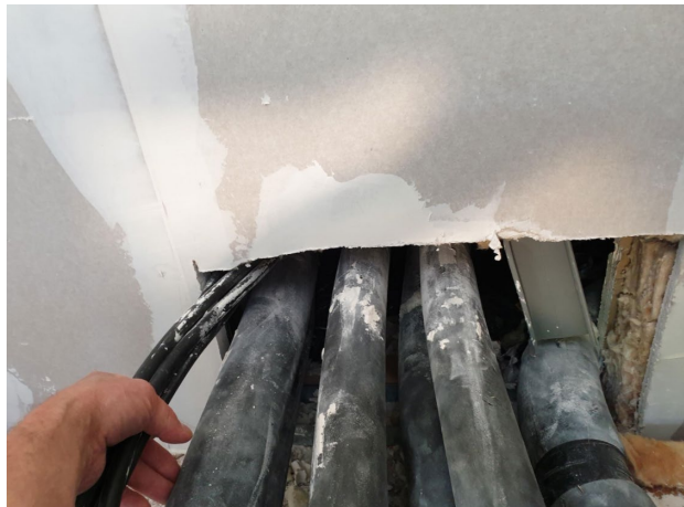
Abbildung 24 - Baustellenbild: Abschottung in LTW
