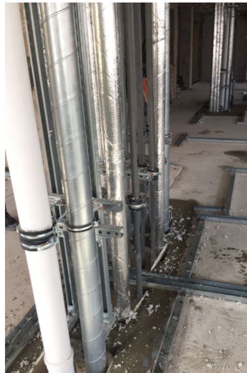
Abbildung 44 - Installationsschacht in Stahlbetondecke
