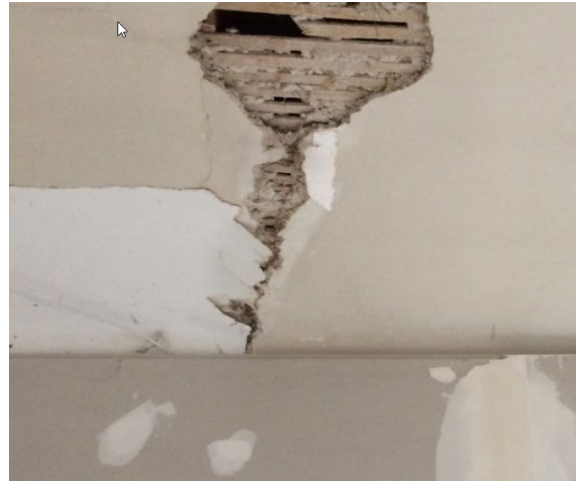
Abbildung 61 - Holzbalkendecke Bestand
