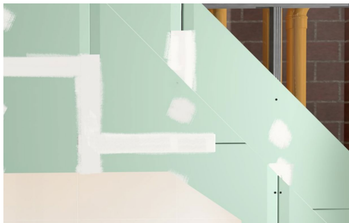
Abbildung 10 - Imprägnierte Gipsplatten mit Spachtelfugen
