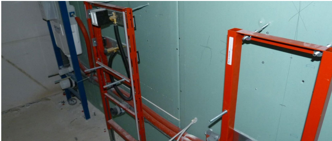
Abbildung 21 - Sanitärtragständer vor einer Trockenbauwand
