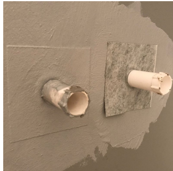
Abbildung 15 - Baustellenbild Rohrdurchführung
