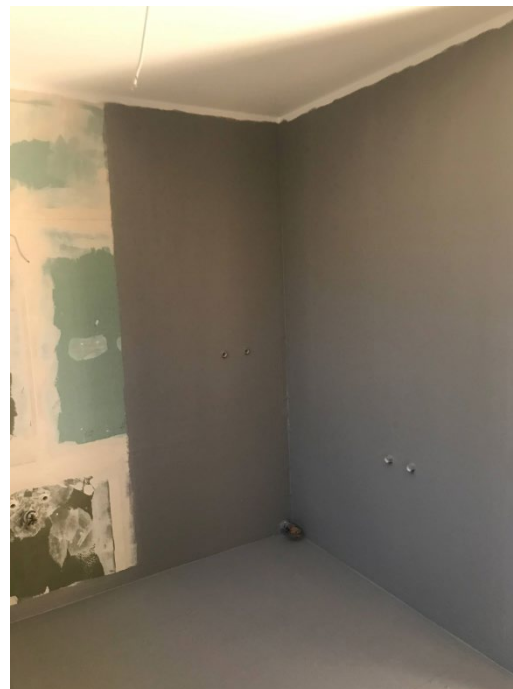
Abbildung 13 - Baustellenbild Flächenabdichtung
