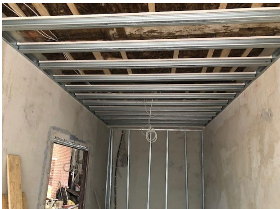
Abbildung 6 - Baustellenbild freitragende Unterdecke
