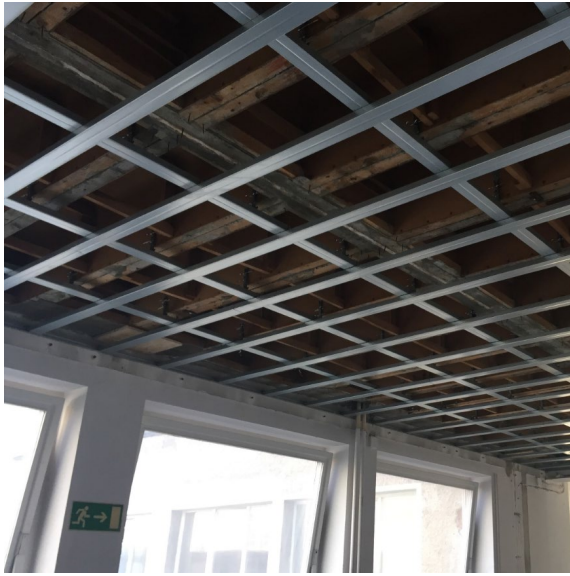
Abbildung 4 - Baustellenbild Unterdecke
