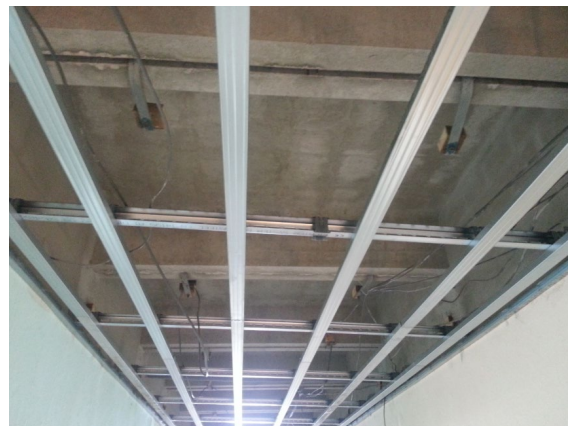
Abbildung 7 - Baustellenbild freitragende Unterdecke
